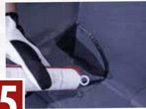
**5** Die Naht der Ecken rundum mit EPDM-Kleber versiegeln.
