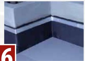
**6** FERTIG - Das Material kann nach Bedarf verputzt und mit einer Abschlussleiste versehen werden.
