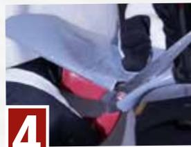
**4** Für Ecken kann das EPDM-Material entsprechend in die passende Form geschnitten werden. Danach das Stück etwas überlappend verkleben.
