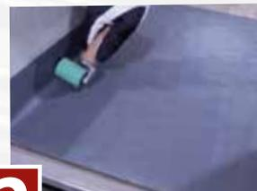
**2** Das Element passend anlegen und mit einer Andrückrolle fest mit der Oberfläche verbinden.
